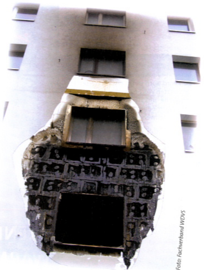
Brandriegel verhindern die Brandweiterleitung in der Dämmebene von WDVS
